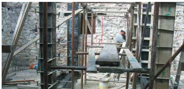
Άποψη από τις εργασίες επισκευής μιας οικίας
